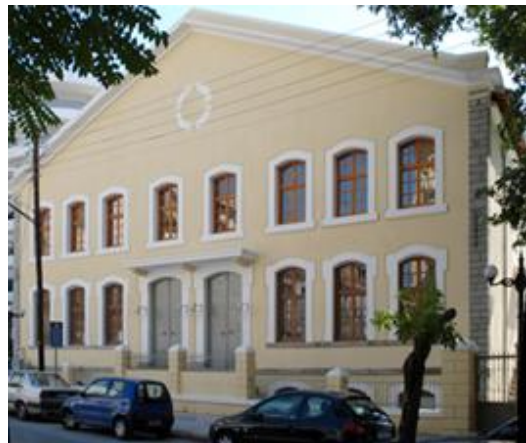
Εικόνα 1: Η Καπναποθήκη Π του ΙΘΠΤ επί της οδού Καπνεργατών 9 στην Ξάνθη.
